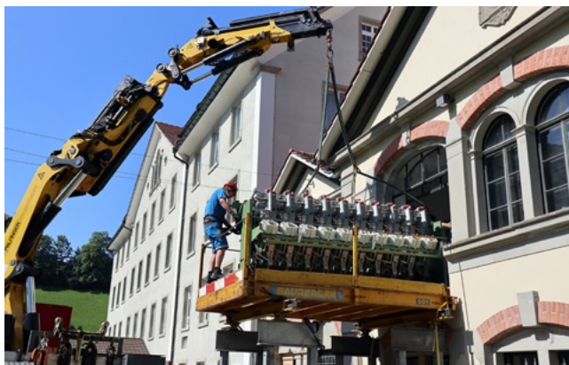
Umzug mittels Kran, Podest und schwerem Werkzeug
